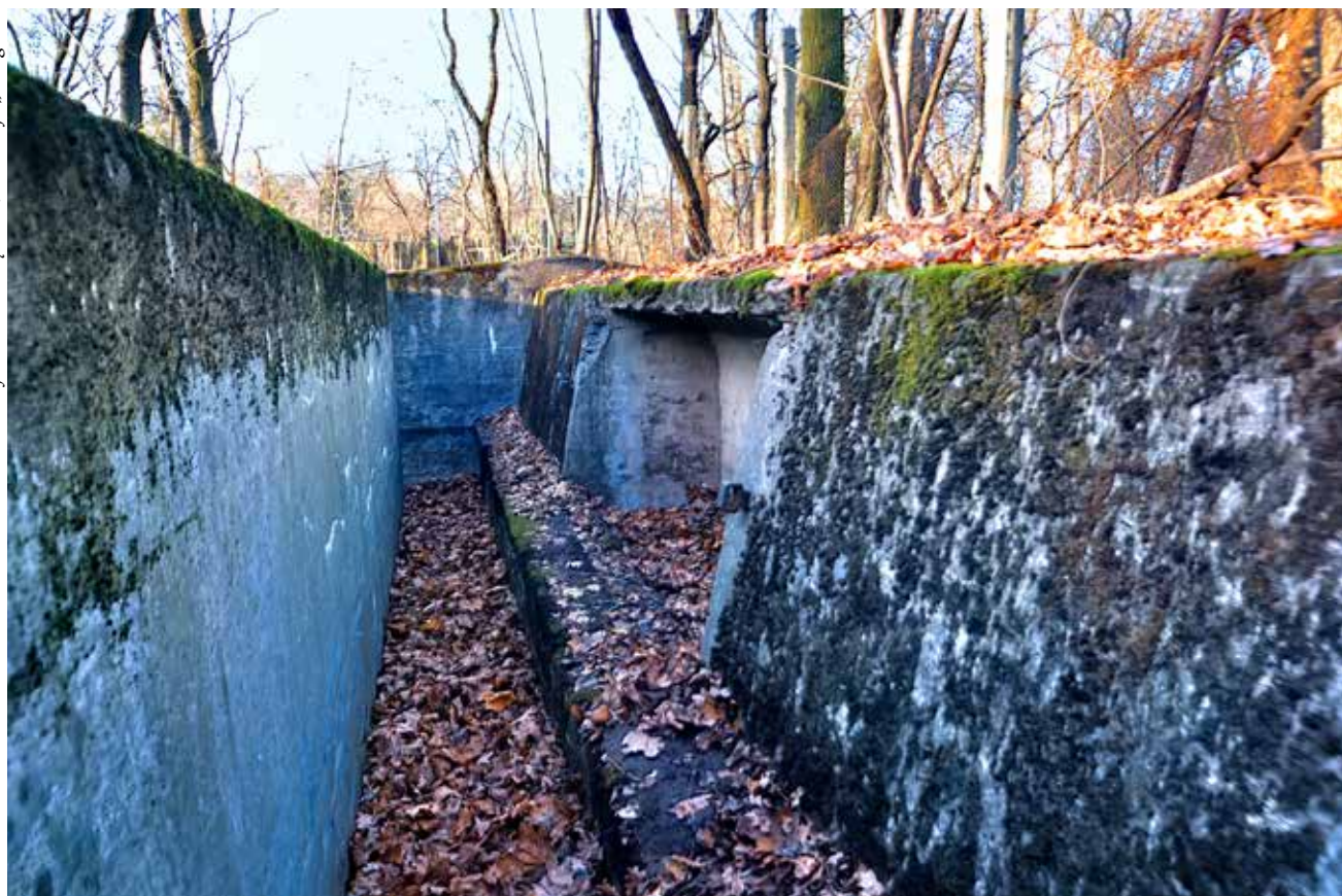
Zachowane w świetnym stanie obetonowane stanowiska strzeleckie
