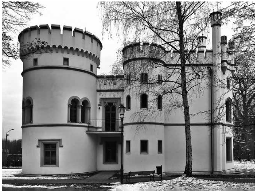
Starannie odrestaurowana oficyna miechowickiego pałacu
