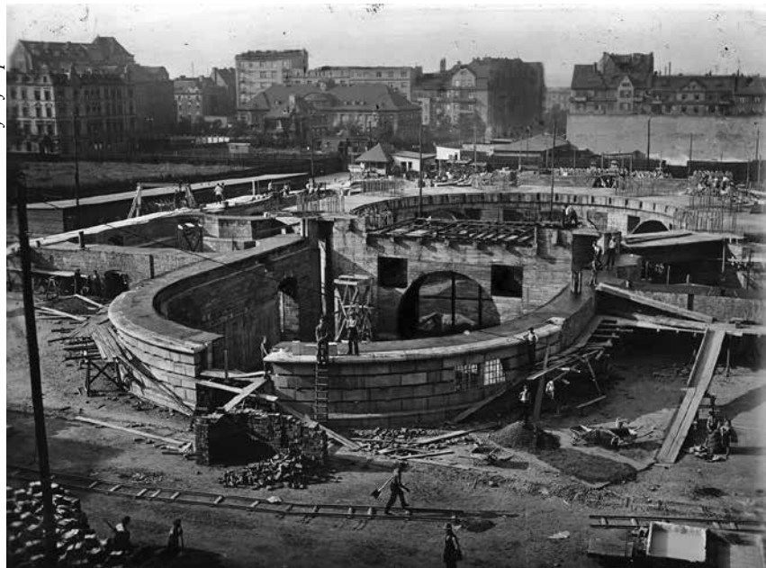
Budowa Archikatedry w Katowicach
