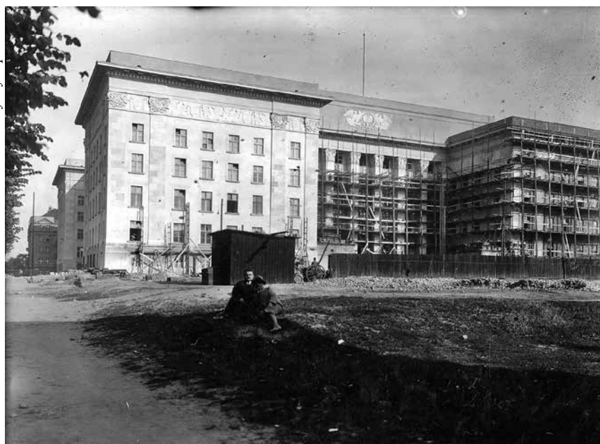
Budowa Urzędu Wojewódzkiego w Katowicach
