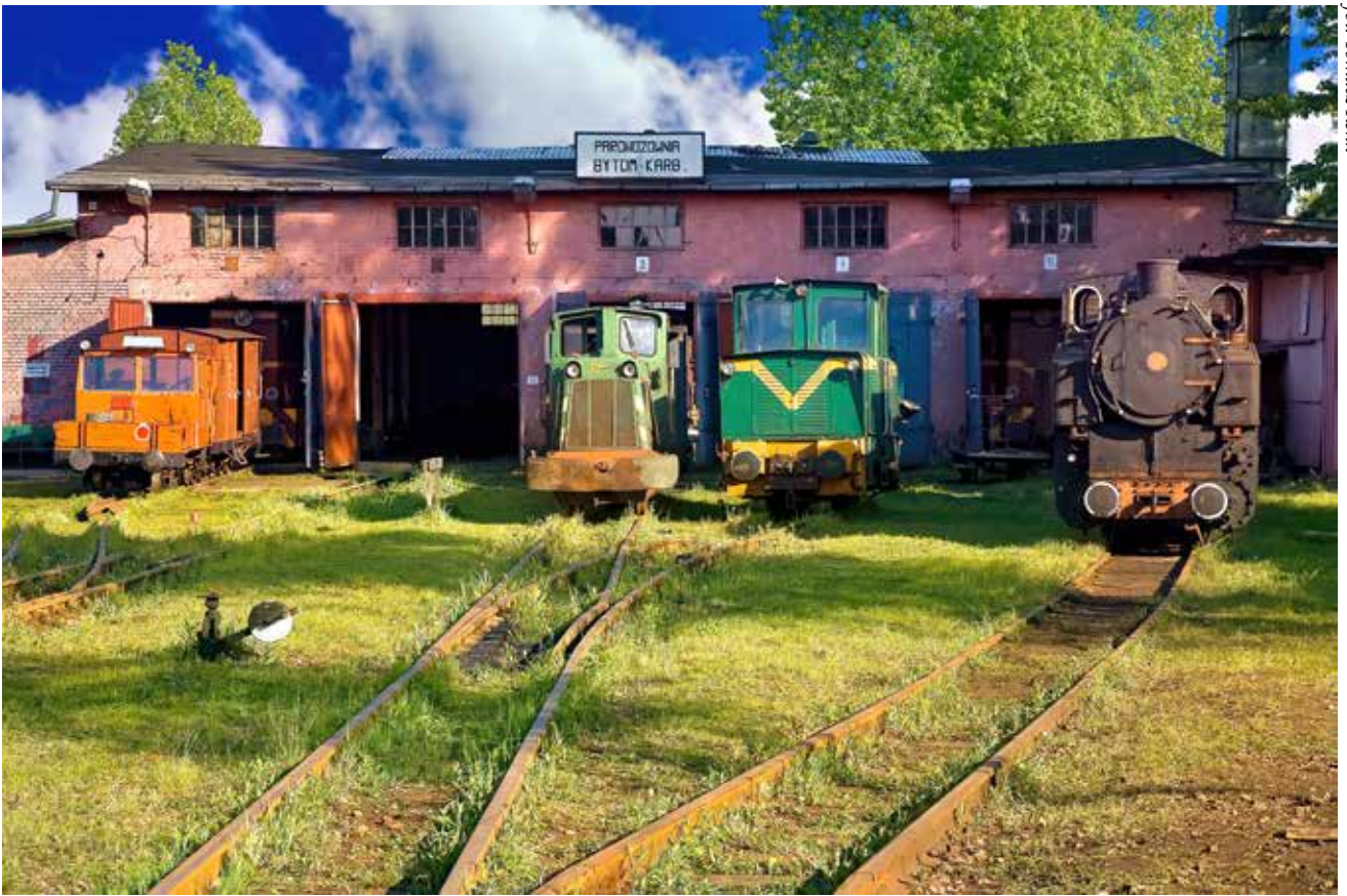
Parowozownia Bytom-Karb Wąskotorowa
