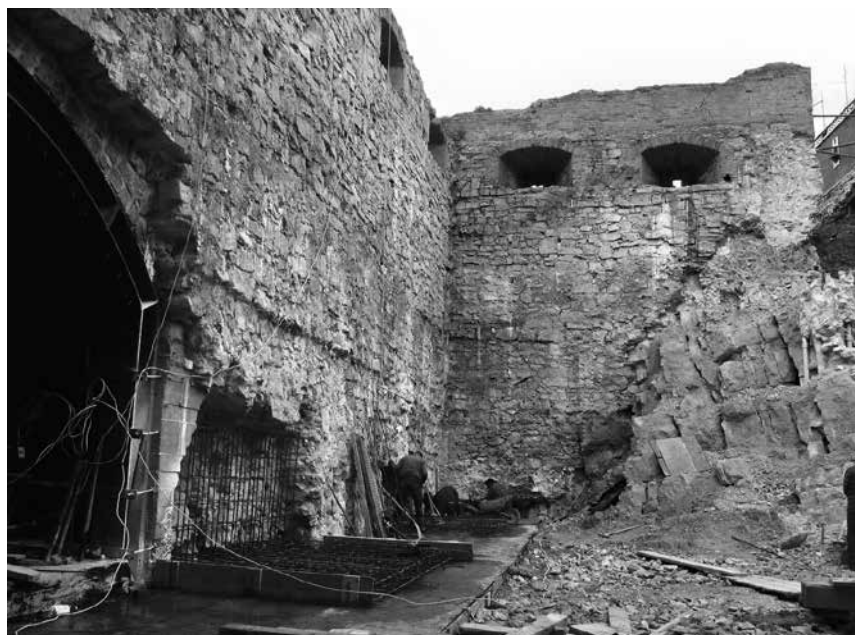
Usuwanie skały i warstw gruzu z wnętrza bastionu, połączone z odsłonięciem oryginalnych otworów strzelniczych w murach XVII wiecznego bastionu (październik 2004)
