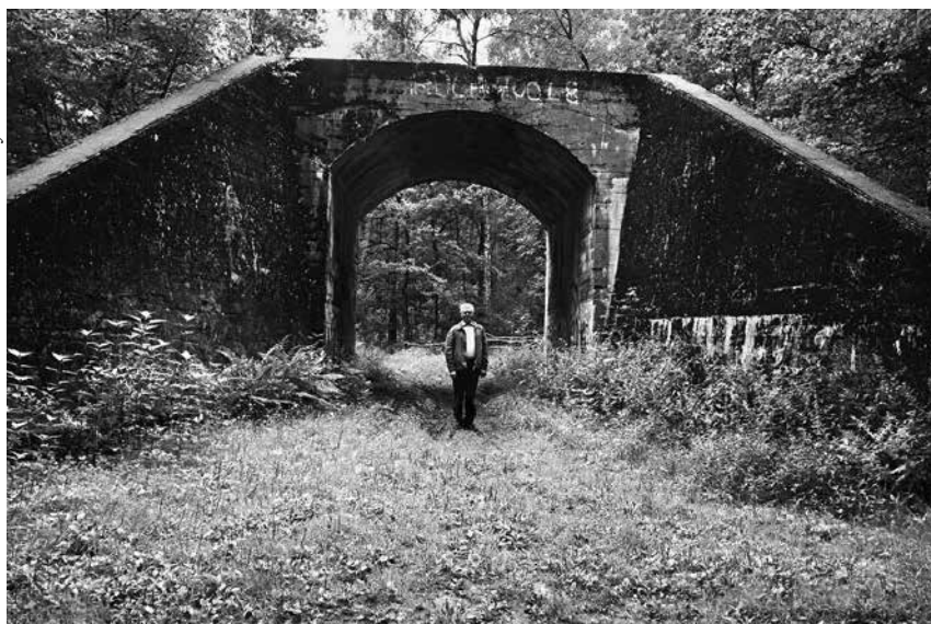
Pozostawiony w lesie wiadukt kolejowy po niedokończonej bocznic kolejowej
