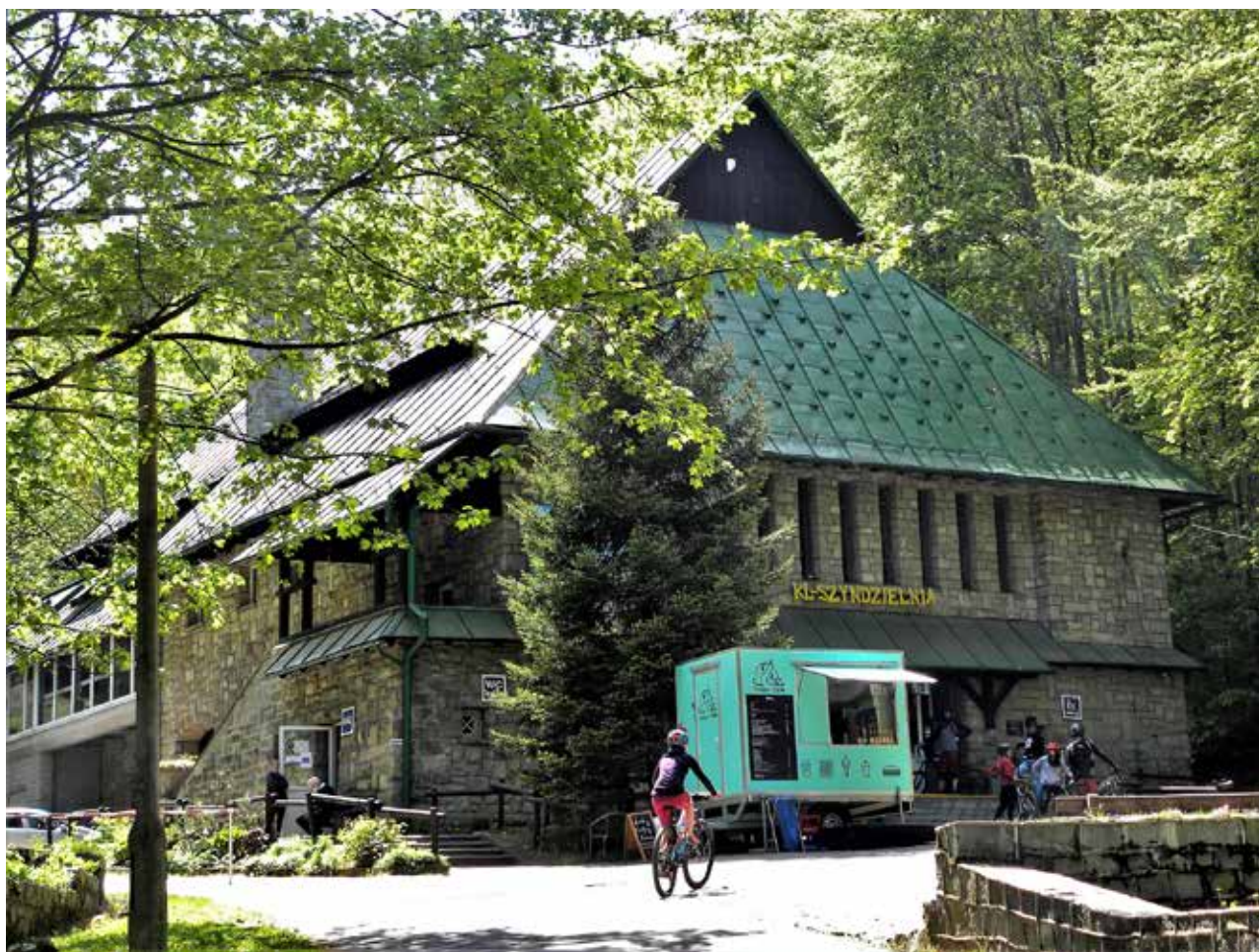
Stacje kolejki linowej na Szyndzielnię (górna i dolna)
