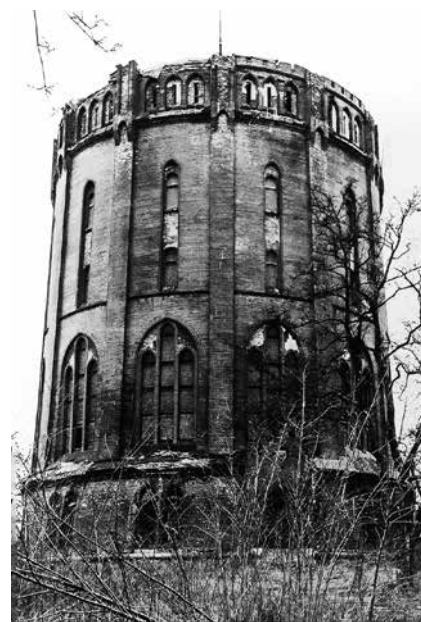
Wieża ciśnię, Gliwice, ul. Sobieskiego. Wysokość – 36 m, średnica – 27 m, pojemność zbiornika – 3000 m 3
