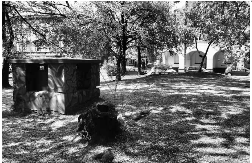
Widok na wejście do schronu LSD i jego wyjście ewakuacyjne (Plac Akademicki, Bytom)
