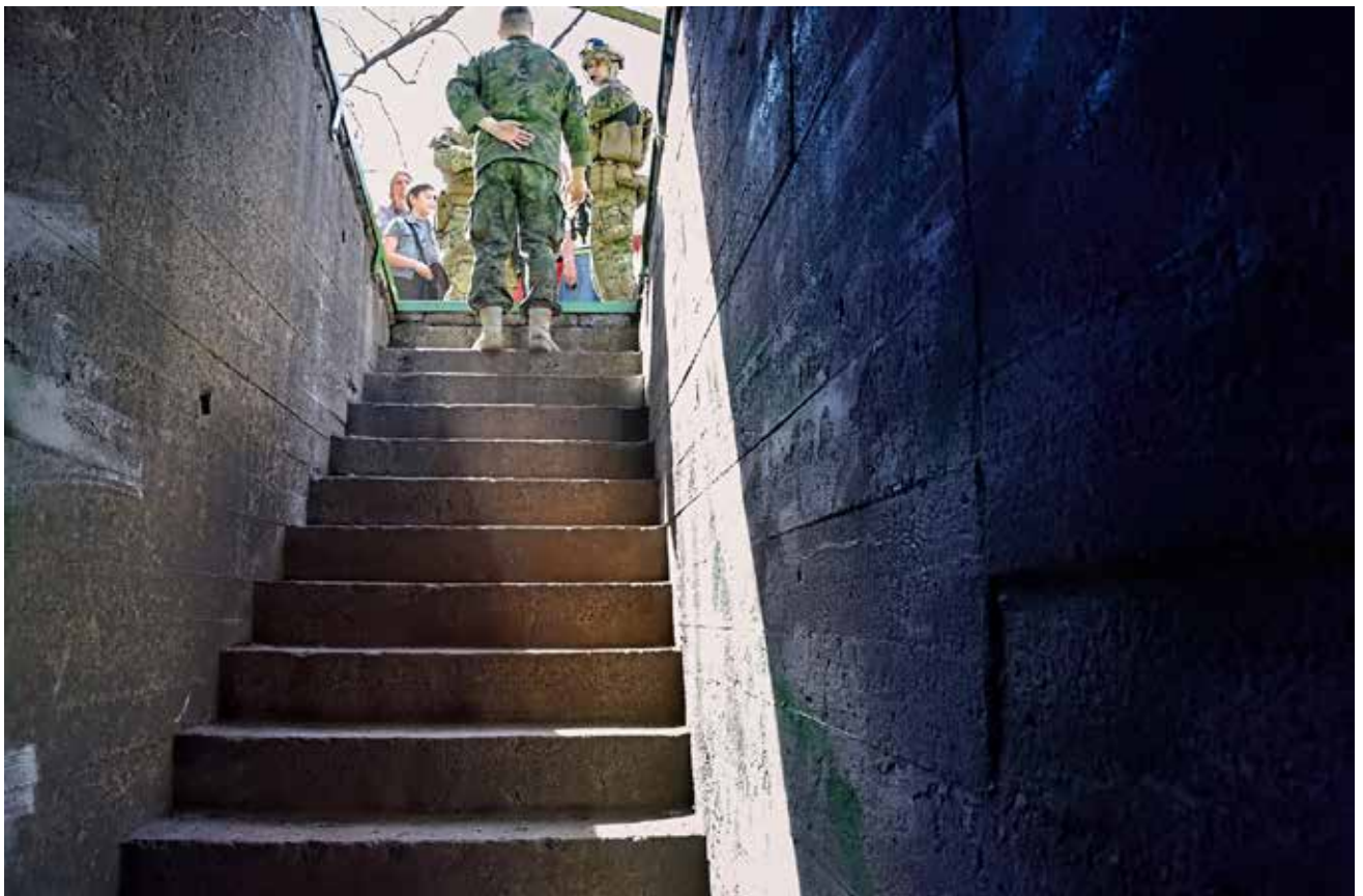
Wejście główne do schronu LSD (schron „Sosabowski”, Plac Akademicki, Bytom)
