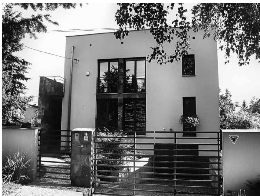
Dom Drodzów – elewacja północna
