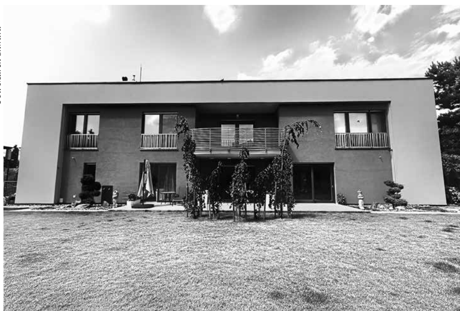
Dom wysokich drzwi – elewacja południowa
