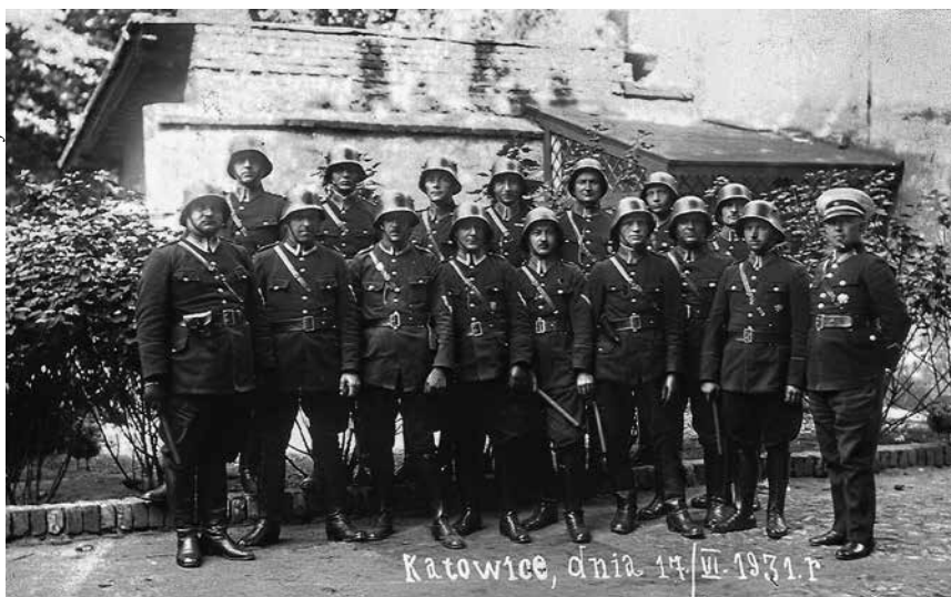
Pluton Komendy Rezerwy PWŚl. w Katowicach, 1931 rok
