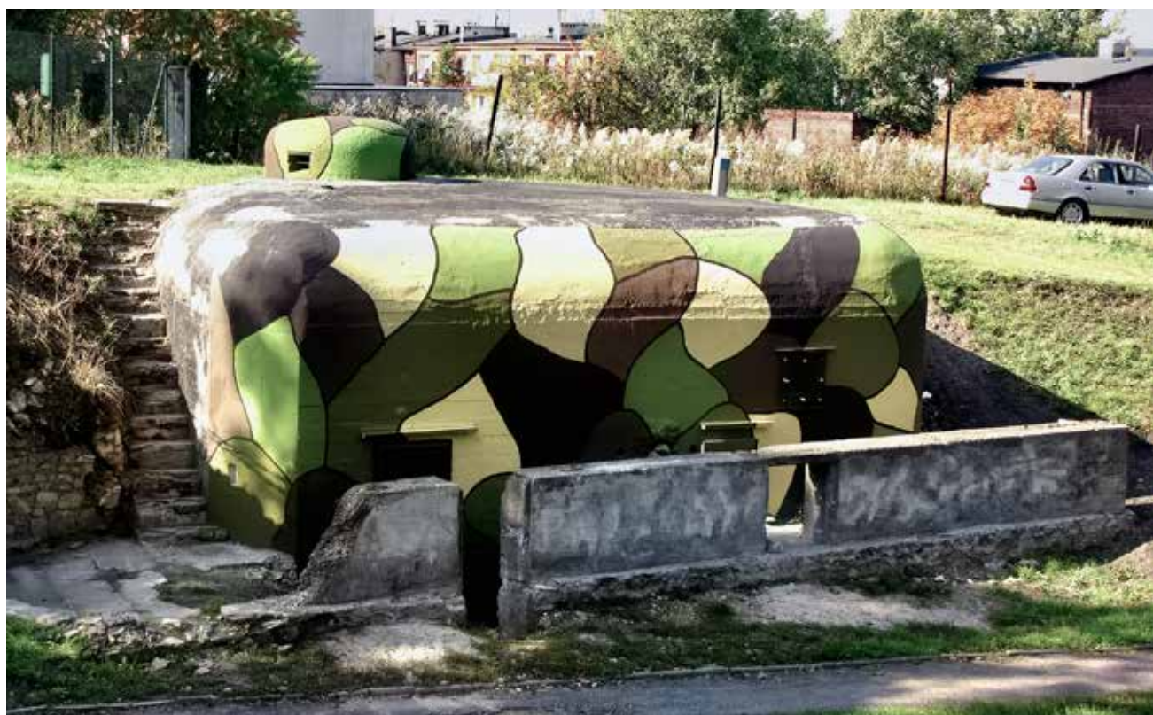
Ciężki schron bojowy ckm przy drodze
