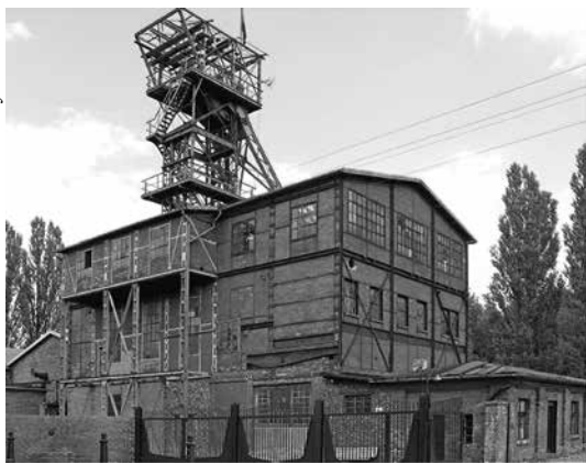
Buildynki nadszybia wentylatorów Joy i wagi, strona południowo-zachodnia. Stan przed rewitalizacją
