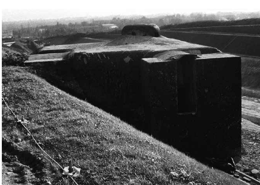
Schron wykopowy na „Wzgórzu 310” podczas budowania autostrady A1
