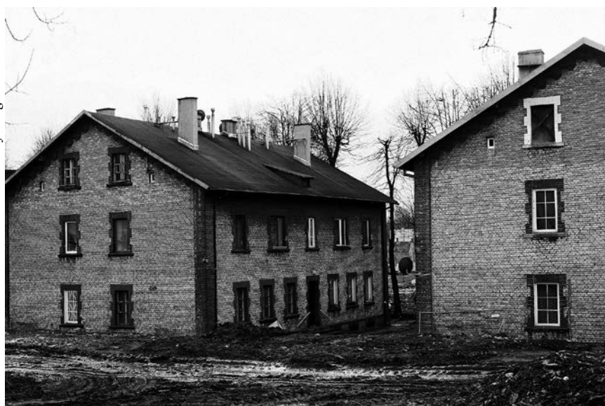
Budynki w Czeladzi posiadają proste, mało zróżnicowane bryły, wykonane zostały z cegły lub kamienia w większości z ubogim detalem architektonicznym.
