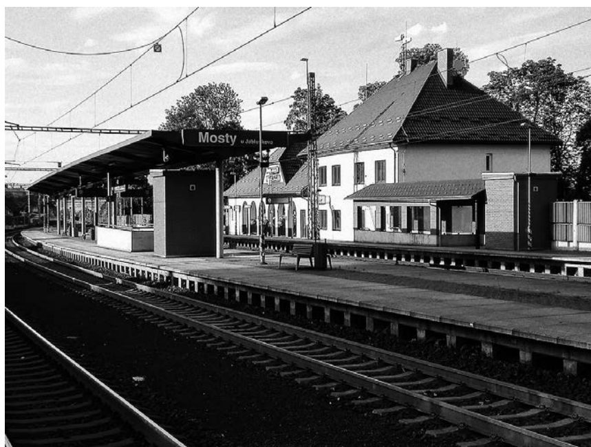
Stacja Mosty koło Jabłonkowa, stan obecny.
