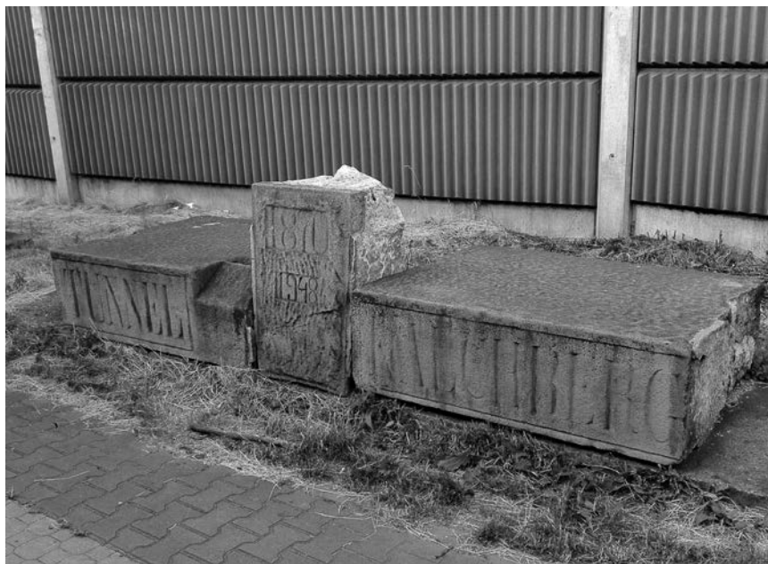
Zachowany na pamiątkę element pierwotnego wlotu do jednego z tuneli z datą budowy 1870. Relikt obejrzieć można na stacji Mosty koło Jabłonkowa.
