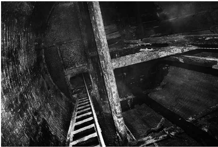
Wnętrze Szybu Południowego
