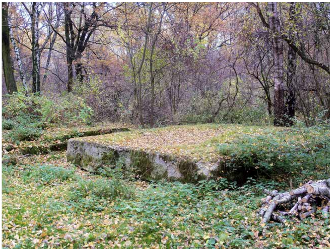
Szyb Południowy obecnie – na zdjęciu betonowa płyta zabezpieczająca wylot szybu.
