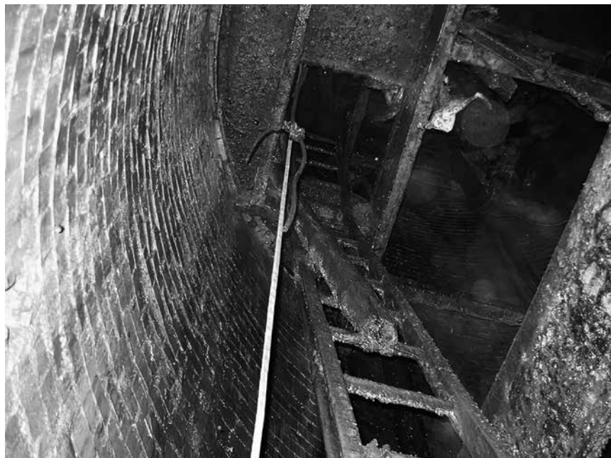
Wnętrze Szybu Południowego
