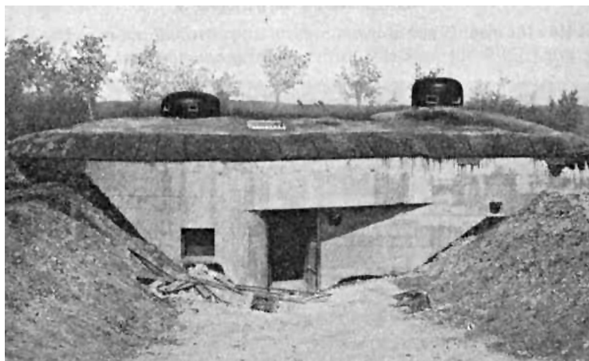
Polski schron bojowy w Niezdarze z czechosłowacką kopułą obserwacyjną – zdjęcie archiwalne z „Denkschrift über die polnische Landbefestigung”, Berlin 1941
