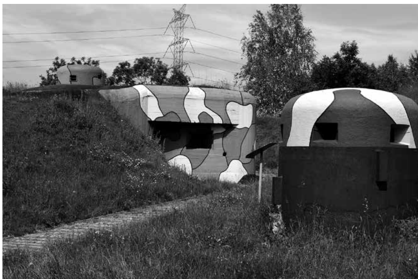
Polski schron bojowy nr 52 w Dobieszowicach – na pierwszym planie uratowana kopuła pancerna ze schronu w Niezdarze
