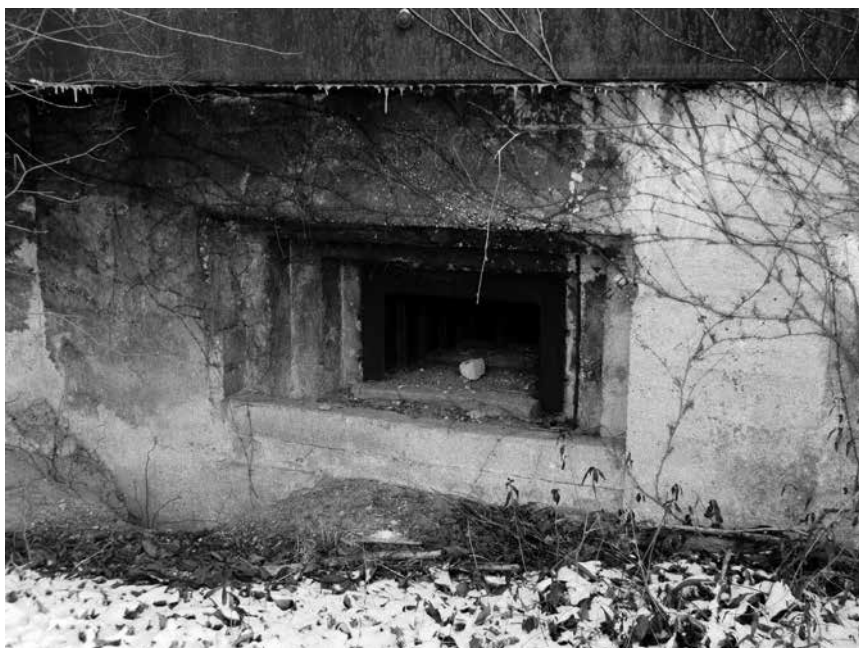
Schron B-Werk Regelbau 116b w Stolarzowicach – czeska płyta pancerna podwójnego ckm-u
