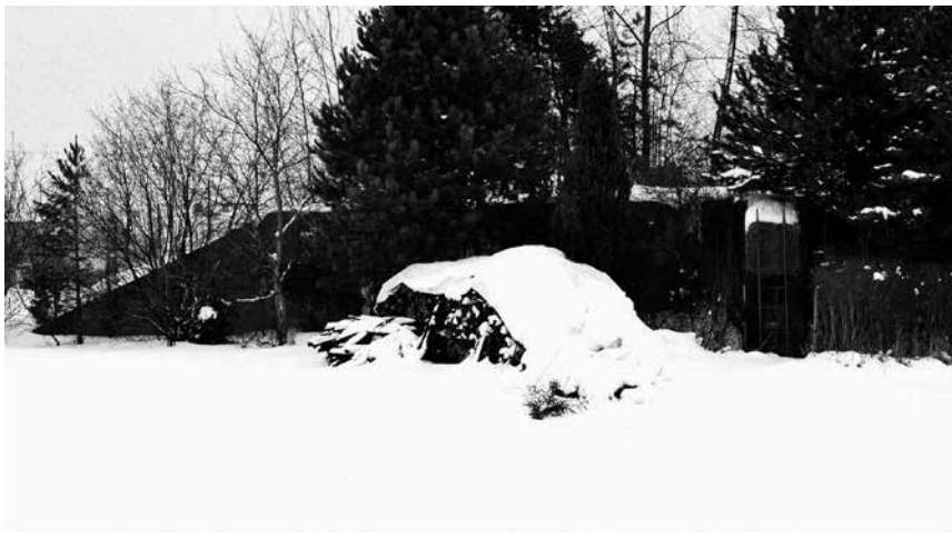
Schron B-Werk Regelbau 116b w Stolarzowicach (styczeń 2019)
