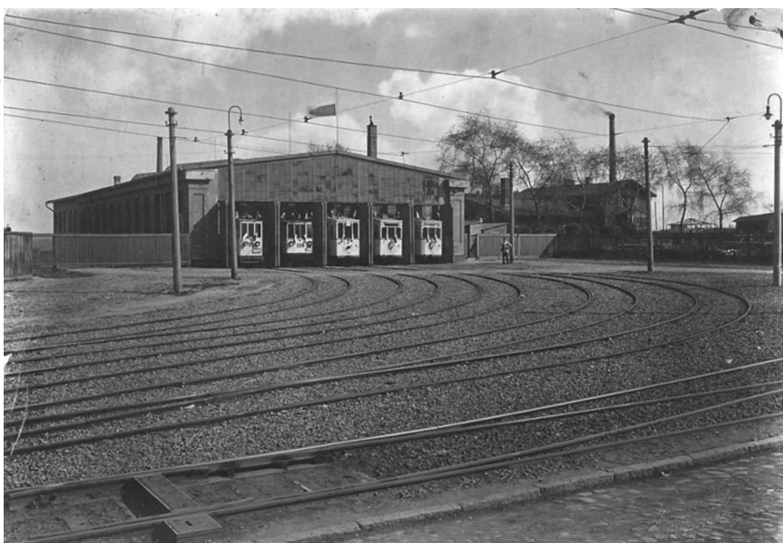
Historyczne zdjęcie zajezdni tramwajowej z roku 1929
