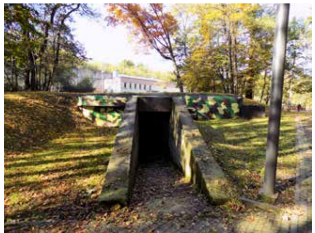
Schron dowodzenia w Chorzowie
