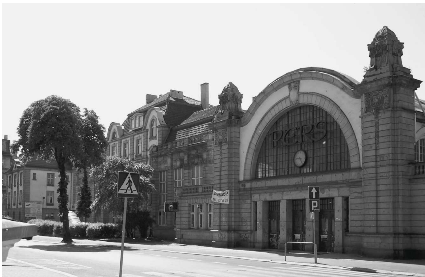
Katowice – stary dworzec
