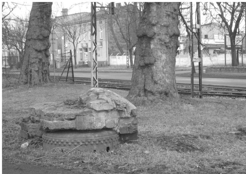
Unikatowy, stalowy Einmannbunkier w Zabrze przy ul. Wolności, zwraca uwagę dodatkowa osłona z cegieł
