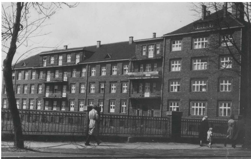
Tak wyglądał w latach 60. XX wieku Dom Prowincjalny Sióstr Służebniczek NMP w Katowicach – Panewnikach. Podczas II wojny światowej skrywał tajną kwaterę Fritza Brachta, gauleitera Górnego Śląska
