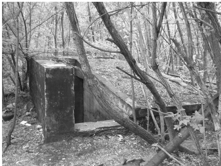
Betonowa kopuła chroniąca klatkę schodową schronu w katowickim Zależu. Obiekt wybudowano pod koniec wojny dla potrzeb niemieckiej kolei
