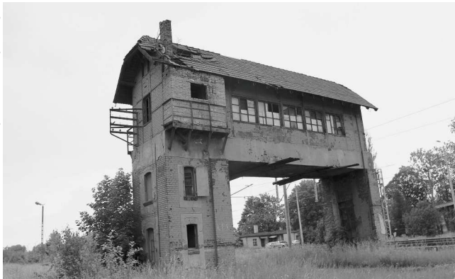
Opuszczona nastawnia bramowa należąca do pyskowskiego węzła kolejowego
