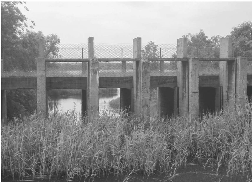
Kanał Gliwicki z jego infrastrukturą towarzyszącą sam w sobie jest zabytkiem techniki i atrakcją turystyczną. Na zdjęciu jaz, który w razie obfitych opadów odprowadza grawitacyjnie nadmiar wody w kanale do położonego nieco niżej jeziora Dzierżno Duże.
