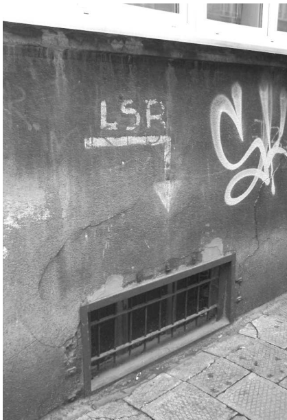
Przy ul. Jordana 10 w Katowicach widać oznaczenie schronu w piwnicy domu mieszkalnego
