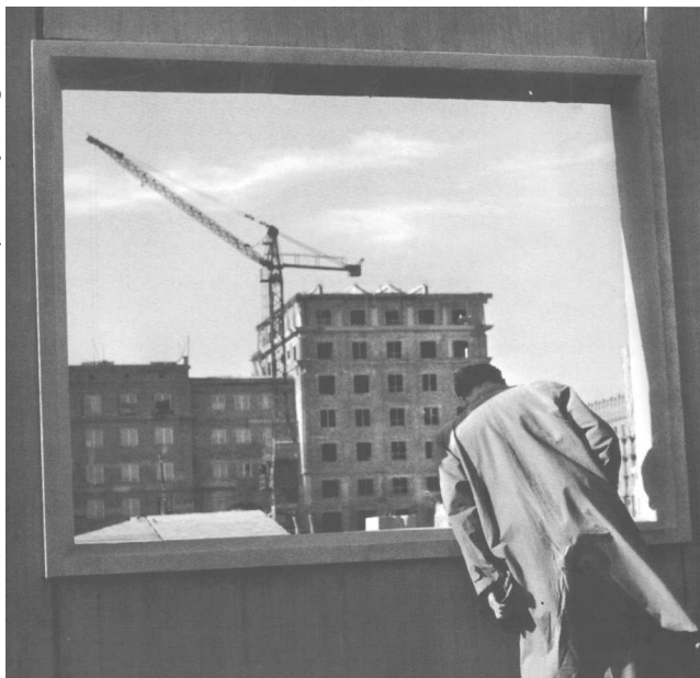
Budowa osiedla Hutniczego, 1956 r.
