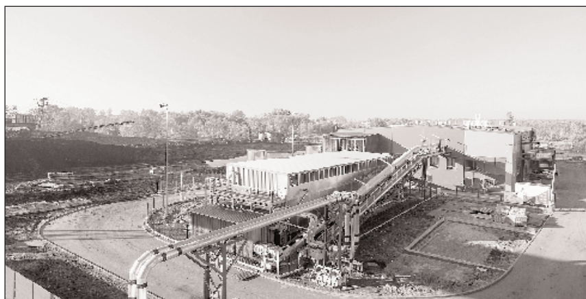
Zakład Produkcji Kompozytowych Paliw Stałych na terenie kop. „Krupiński”
