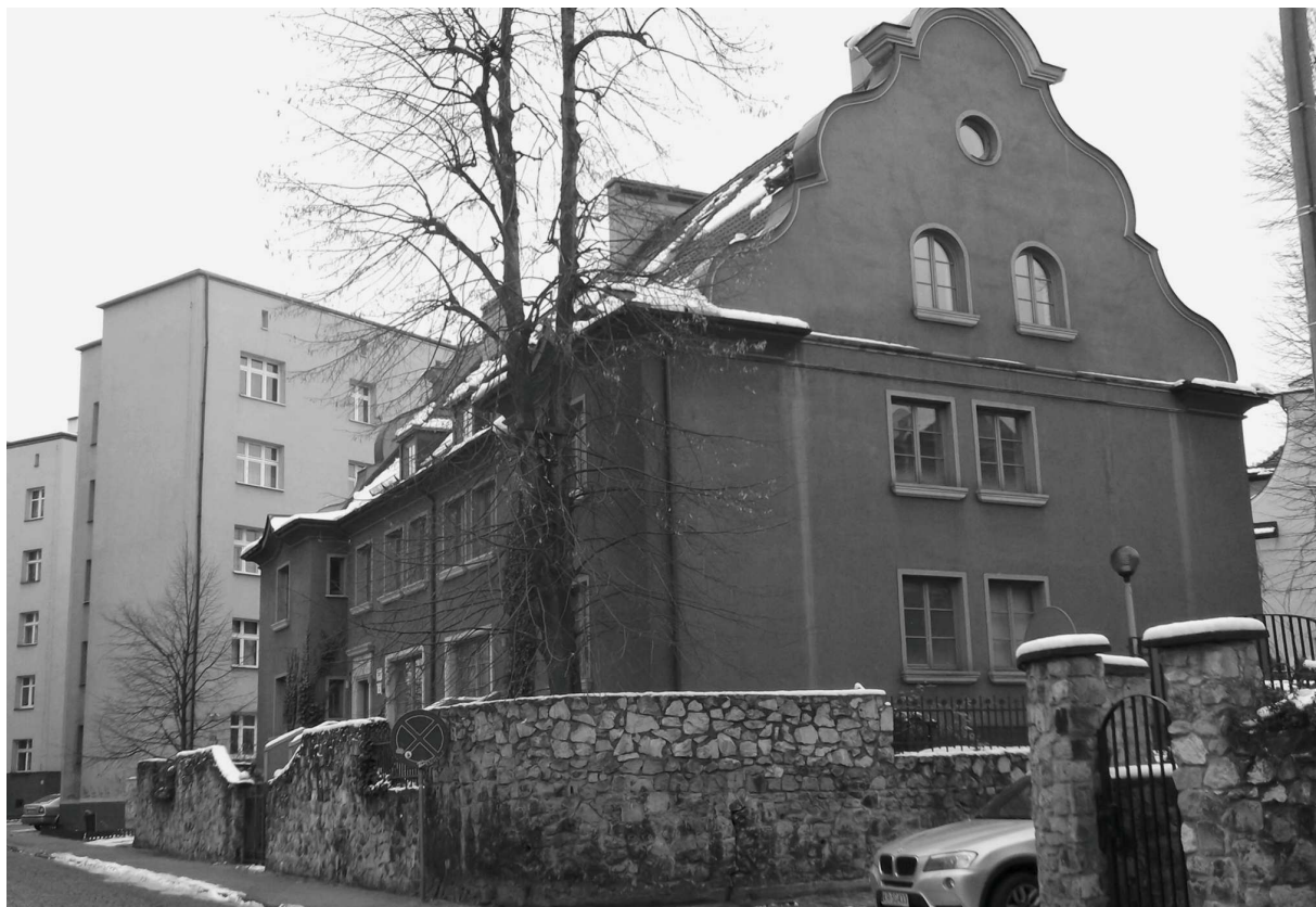
Dom przy ul. Jordana 9, stan obecny.
