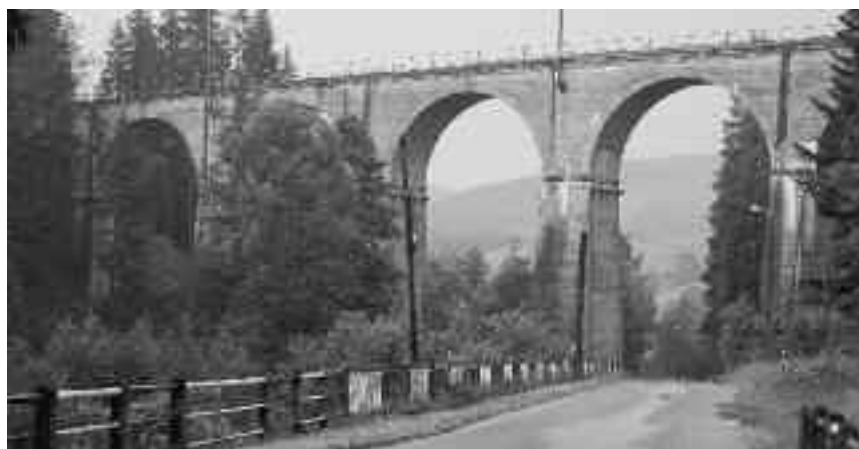
Wiadukt kolejowy w Wiśle Głębcach ponad dolinę Łabajowa, wzniesiony w latach 1931-33 przez firmę Ksawerego Goryanowicza
