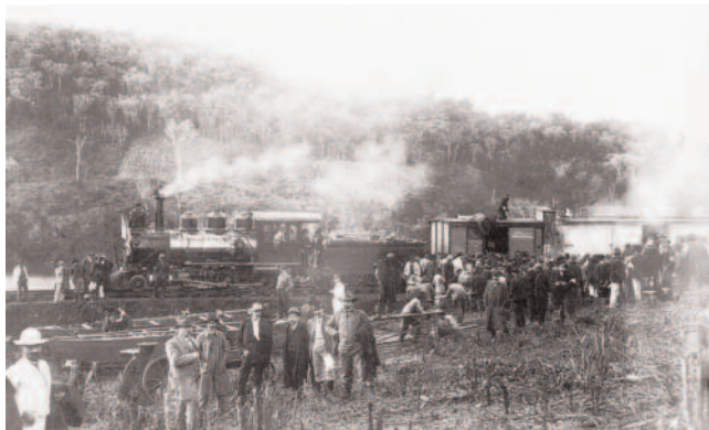
Przybycie 1-ej maszyny do brzegów rzeki Uruguay. Na froncie centralne biuro techniczne, w głębi ugaszczanie robotników w dniu 17 lipca 1910 r. W pelerynie W. Wierzbowski, z prawej Bol. Prysak itd. Zdjęcie Teofila Witolda Wierzbowskiego i jego oryginalny podpis.
