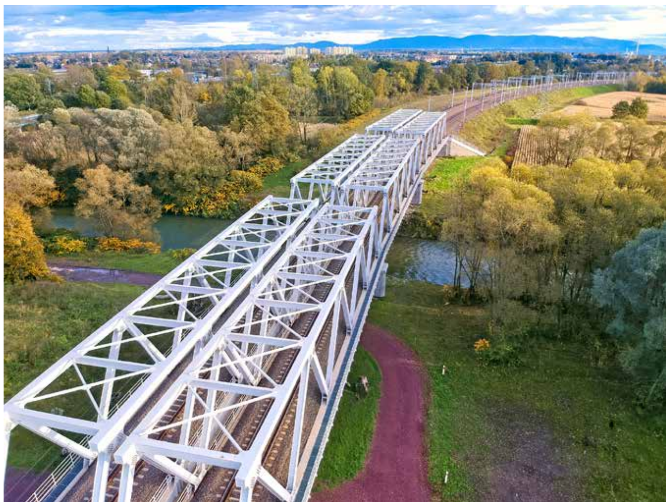
Nowy most kolejowy nad Wisłą – ważny obiekt komunikacyjny na uczęszczanej trasie kolejowej z Górnego Śląska w Beskidy
