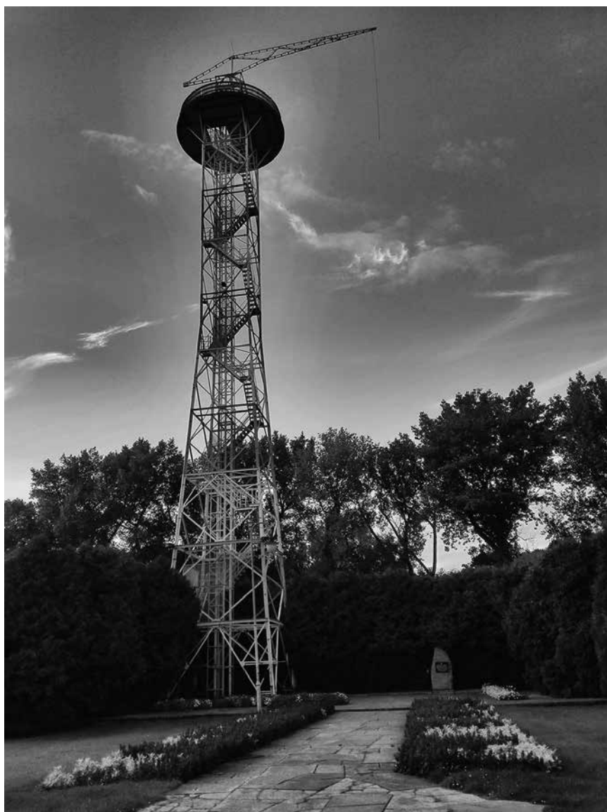
Wieża spadochronowa w Parku Kościuszki w Katowicach za sprawą literatury przeszła do legendy
