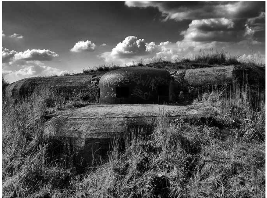
Jeden ze schronów bojowych Punktu Oporu Radoszowy w Rudzie Śląskiej Kochłowicach, który w 1939 roku strzegł przedmieść Chorzowa i Katowic.
