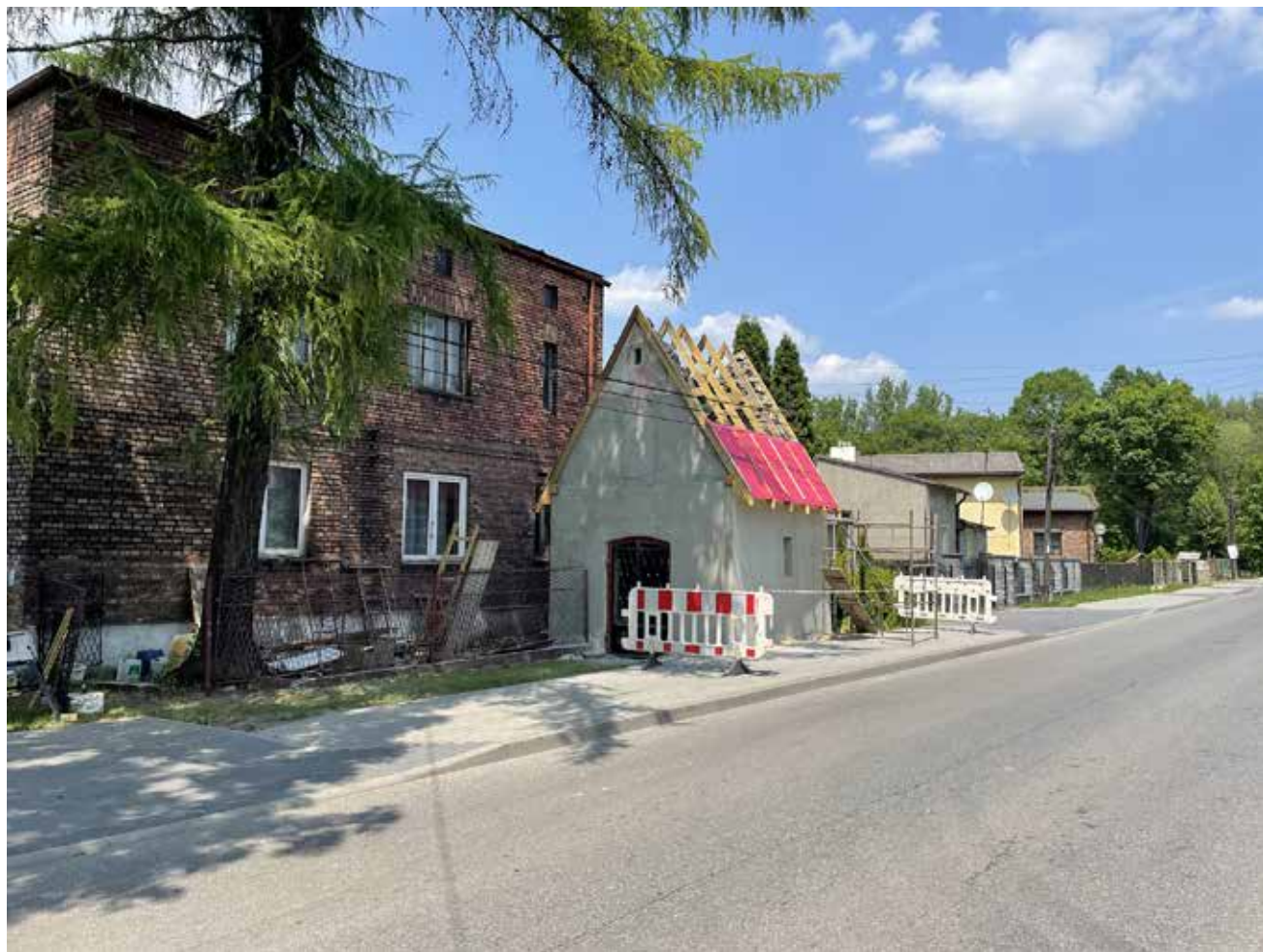
Prace renowacyjne przy zabytkowej kapliczce w Strzemieszycach Małych.
