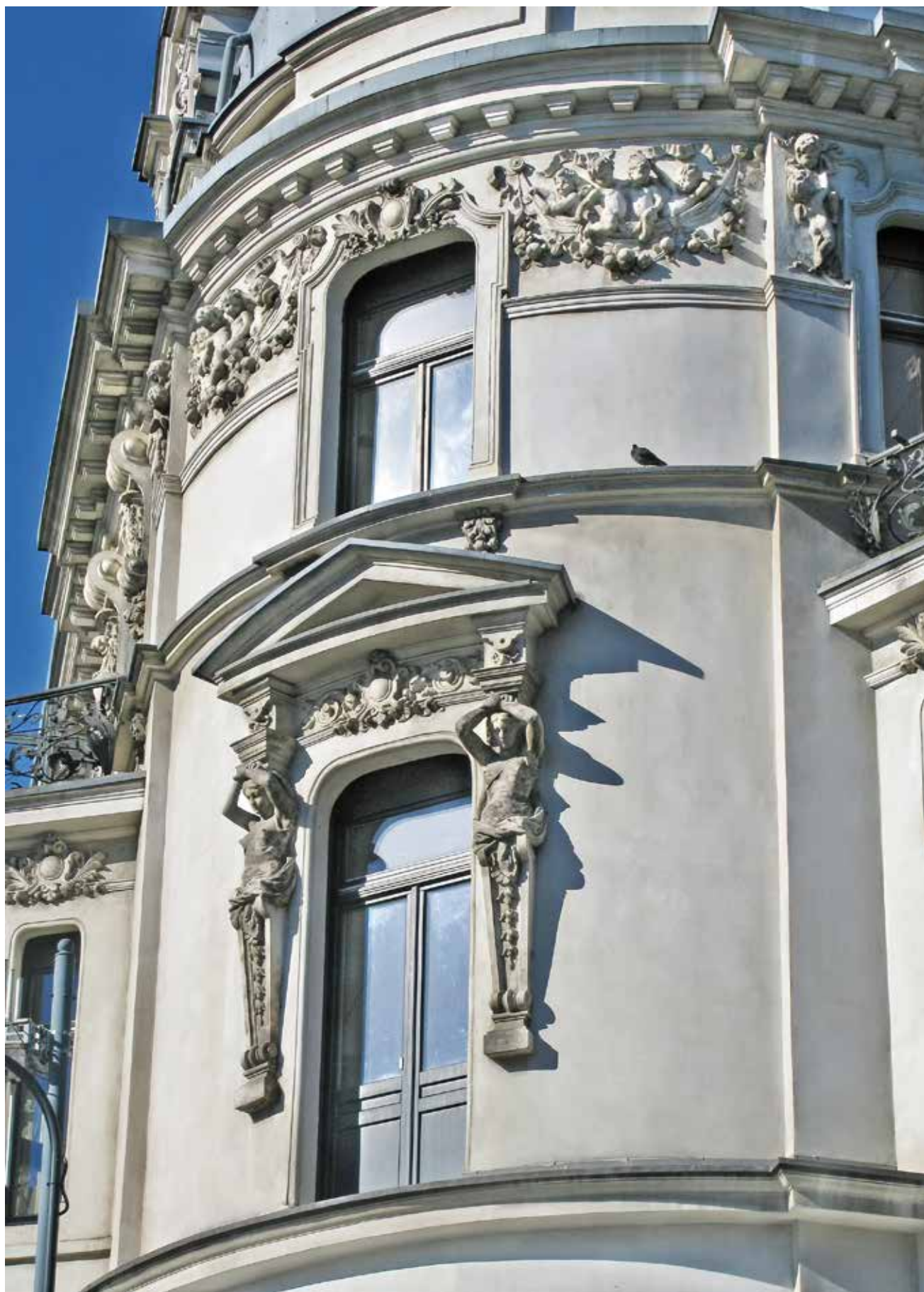
Elementy secesyjne kamienicy u zbiegu ulic Stawowej oraz 3 Maja. Rok 2017. Fot. Józef Ligęza, fotografia z albumu „Katowice miasto przemian i muzyki”
