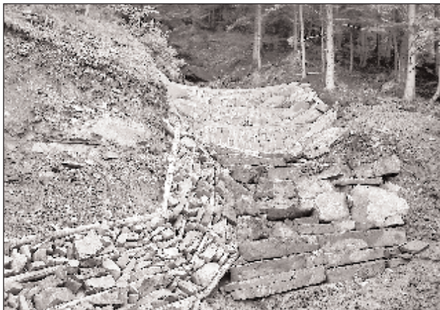
Nadleśnictwo Bielsko: zabudowa potoku Bila, spowalniająca spływ wód
