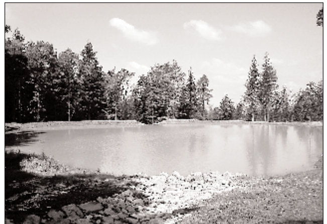
Jeden z trzech kaskadowych zbiorników retencyjnych w Lipniku
