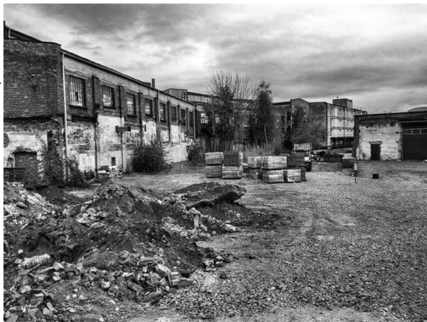
W latach powojennych częstochowski przemysł odbudowywał się ze zniszczeń. Na zdjęciach zabudowa fabryczna pamiętająca tamte czasy.
