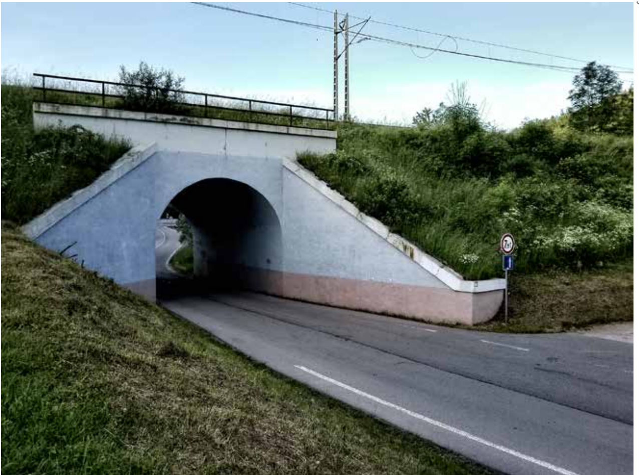
Wiadukt kolejowy za stacją Skalité-Serafinov (obecnie Słowacja; w 1939 roku terytorium II RP), w pierwszych godzinach wojny poległ tu polski żołnierz z placówki broniącej granicy i linii kolejowej
