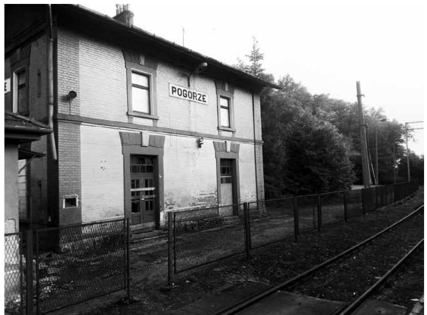
Opuszczony dworzec kolejowy w Pogórze pod Skoczowem. W 1939 roku polski ostrzał z jego okolicy wspierał obronę nieistniejących już obecnie schronów w pobliżu
