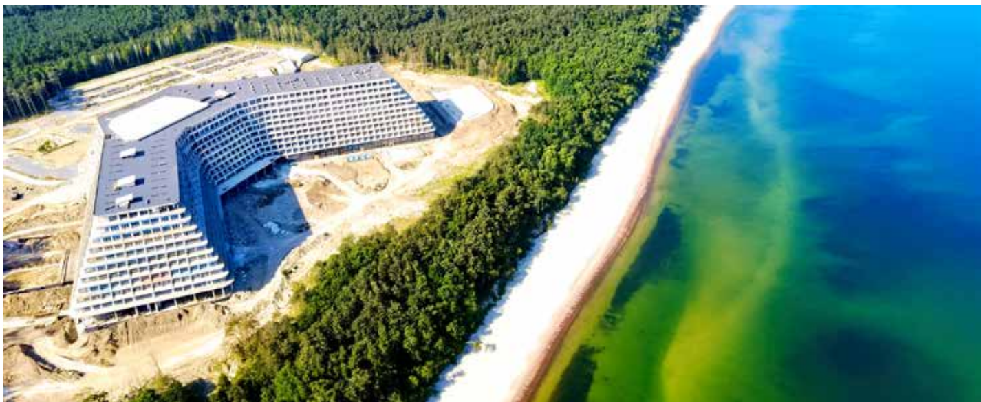
Pobierowo, hotel „Gołębiewski” w budowie
