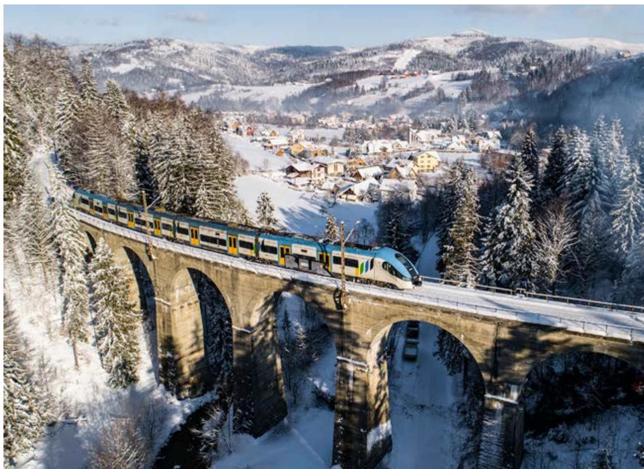
Wiadukt kolejowy w Wiśle Łabajowie. Fot. R. Neumann.
