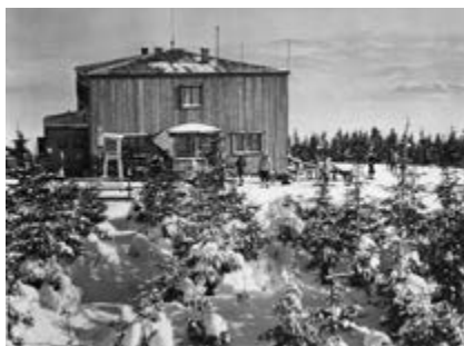
Skrzyczne – dawne schronisko w roku 1964
