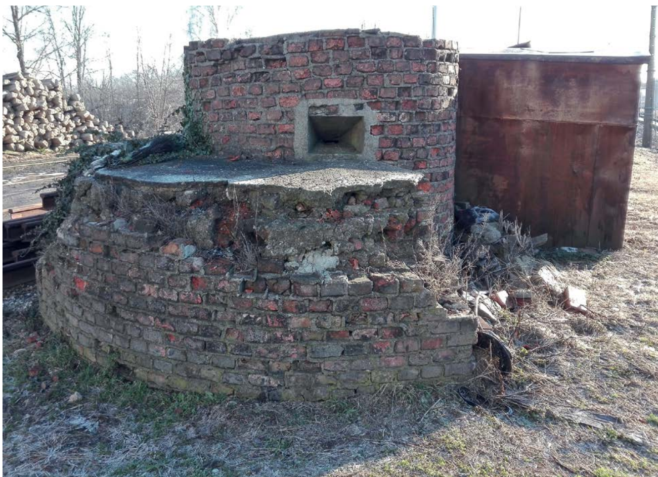
Niemcy latem 1944 nadali Częstochowie status „miasta-twierdzy”, które miało być bronione do ostatniego żołnierza. Na zdjęciu niemiecki schron obserwacyjno-wartowniczy w rejonie stacji kolejowej Częstochowa Raków. Fot. Tomasz Bienek
