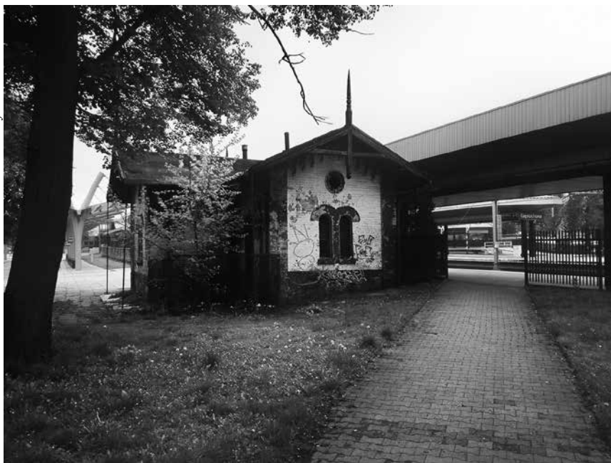
Rok 1944 zapisał się w historii Częstochowy przybyciem pociągów z tysiącami deportowanych robotników przymusowych, więźniów i jeńców. Transporty te mijaly ten budynek – zachowany do dziś relikwiny infrastruktury dawnego częstochowskiego dworca.
