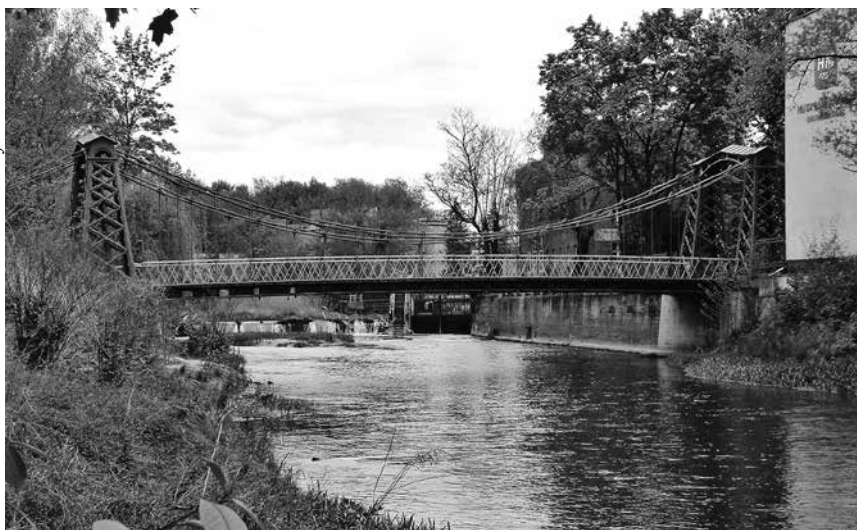
Most w Ozimku został gruntownie odrestaurowany w latach 2009–2010
