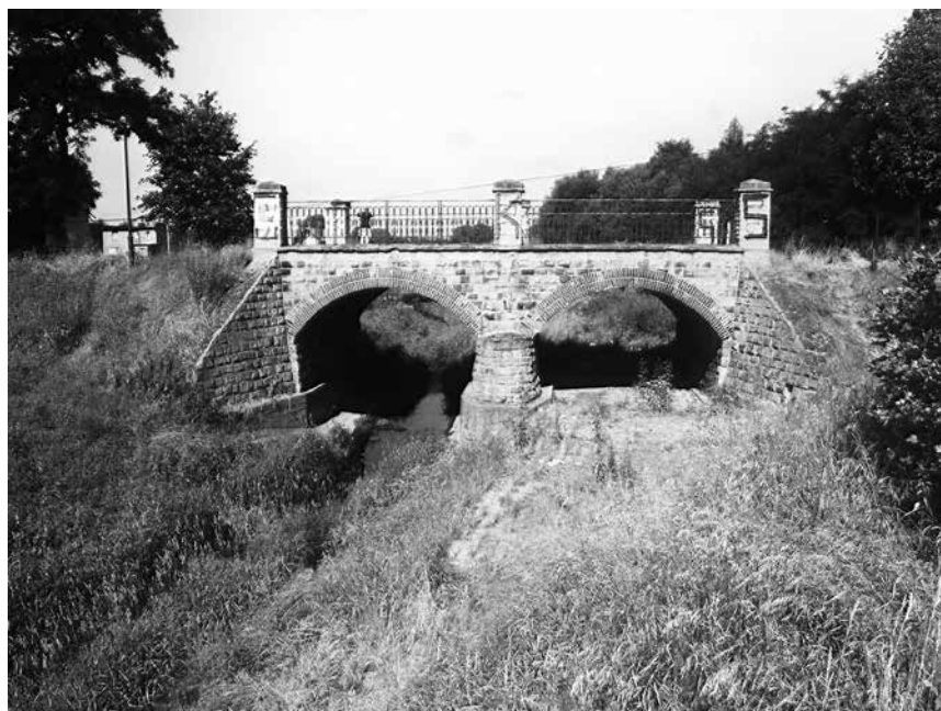
Katowice-Podlesie – most nad rzeką Mleczną
